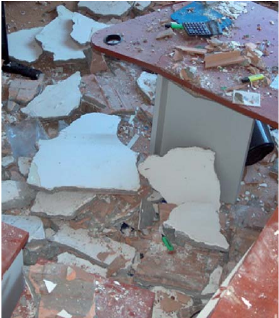
In alto: un solaio in laterocemento con presenza di sfondellamento delle pignatte In basso: gli effetti dello sfondellamento
