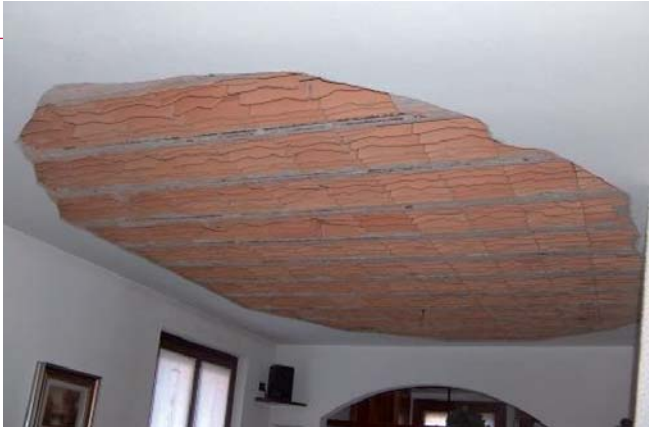
In alto: un solaio in laterocemento con presenza di sfondellamento delle pignatte In basso: gli effetti dello sfondellamento
